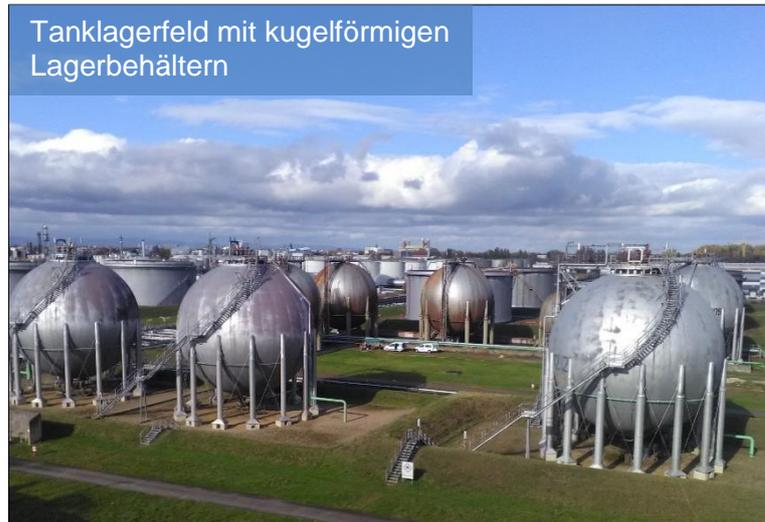
Bei der Auswahl des Prüfverfahrens kam trotz des relativ großen Volumens der Behälter von ca. 2000 m<sup>3</sup>, bedingt durch die Kugelform, nur die sogenannte „nasse Vermessung“ (auch als Ausliterung bezeichnet) infrage.
