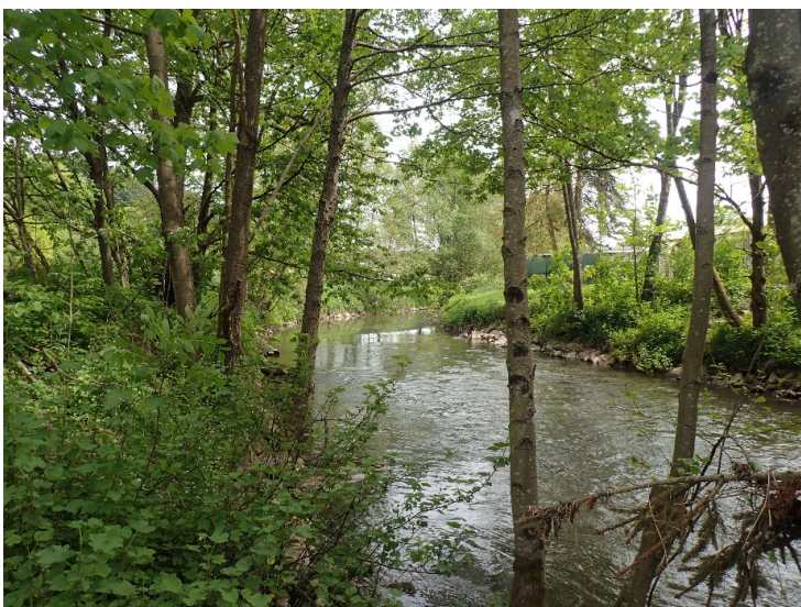
Bild 5: Die Ufer sind bereits durch Steinschüttung gesichert.
