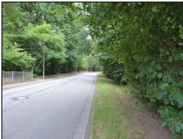
Abb. 10: Sicht auf den Straßenraum der Leipziger Straße im Bereich des geplanten Standortes des Beckens A1
