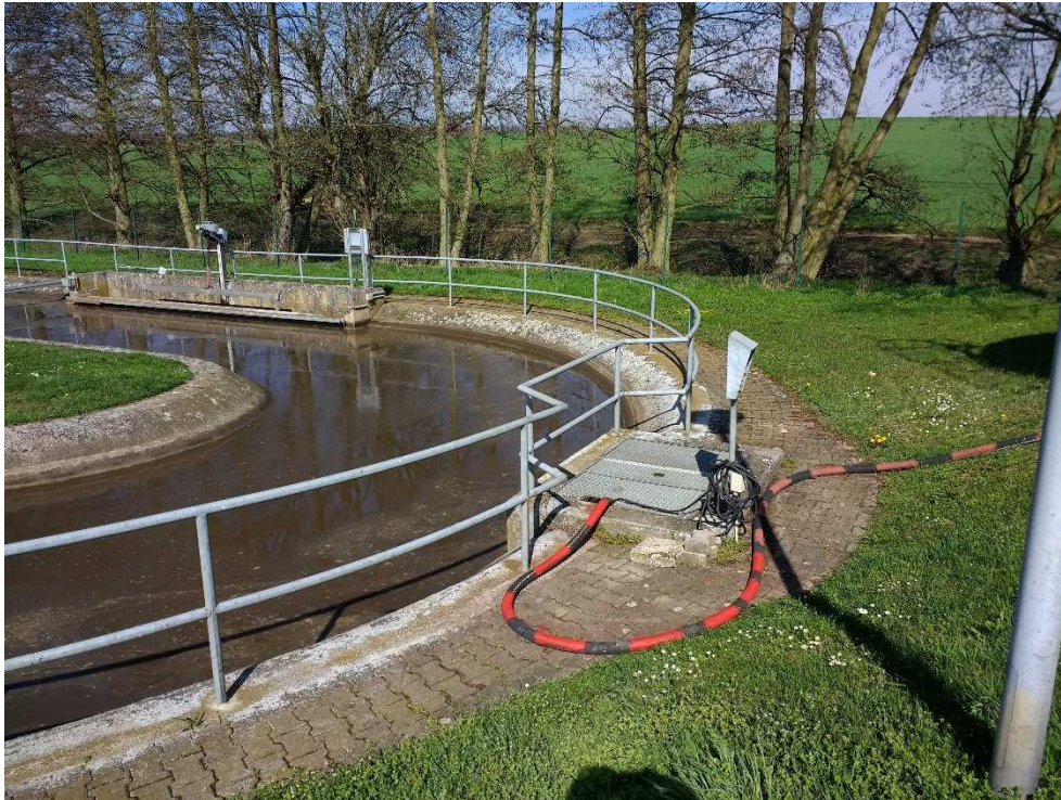
Überschussschlamm pumpstation
