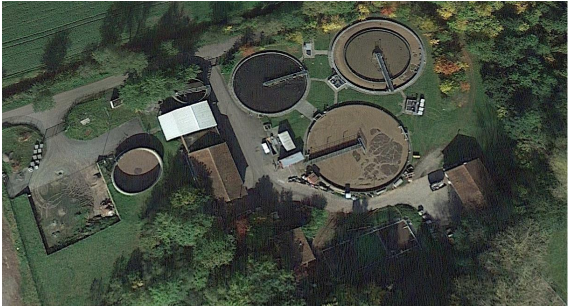
Abbildung 1: Kläranlage Buchholz (Quelle: Google Earth)
