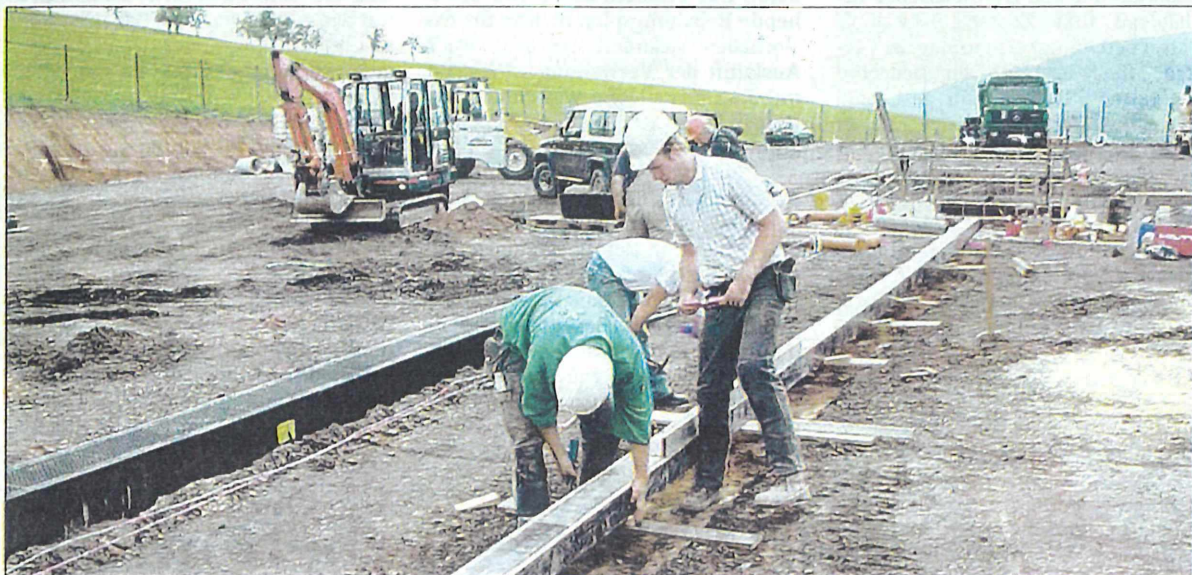
Erdgas-Probebohrung in Theisbergstegen: Die Vorarbeiten gehen zügig voran.
