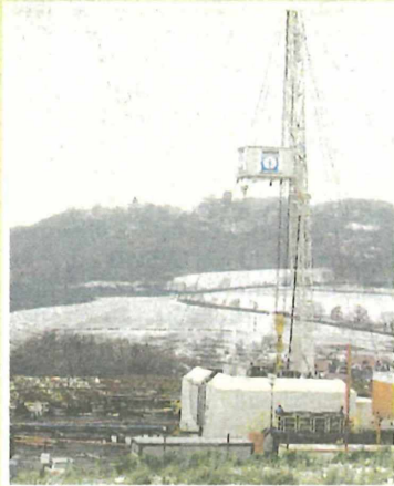
Bis zur Tiefe von 2000 Meter soll die Probebohrung gehen. —FOTO: SAY
