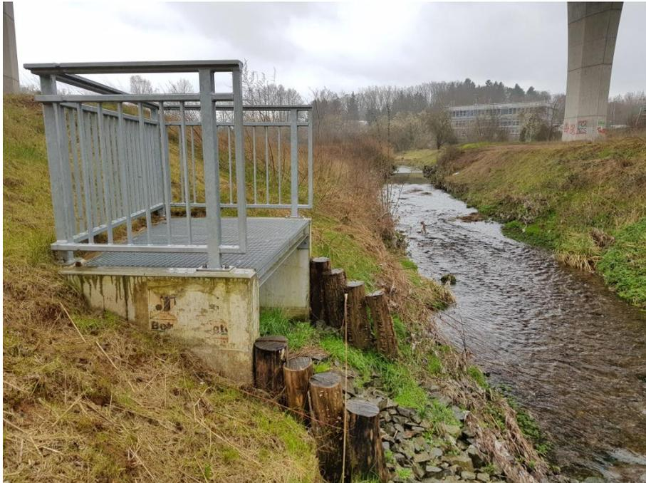
**Abbildung 3 Auslaufbauwerk des Regenrückhaltebeckens A 6**
