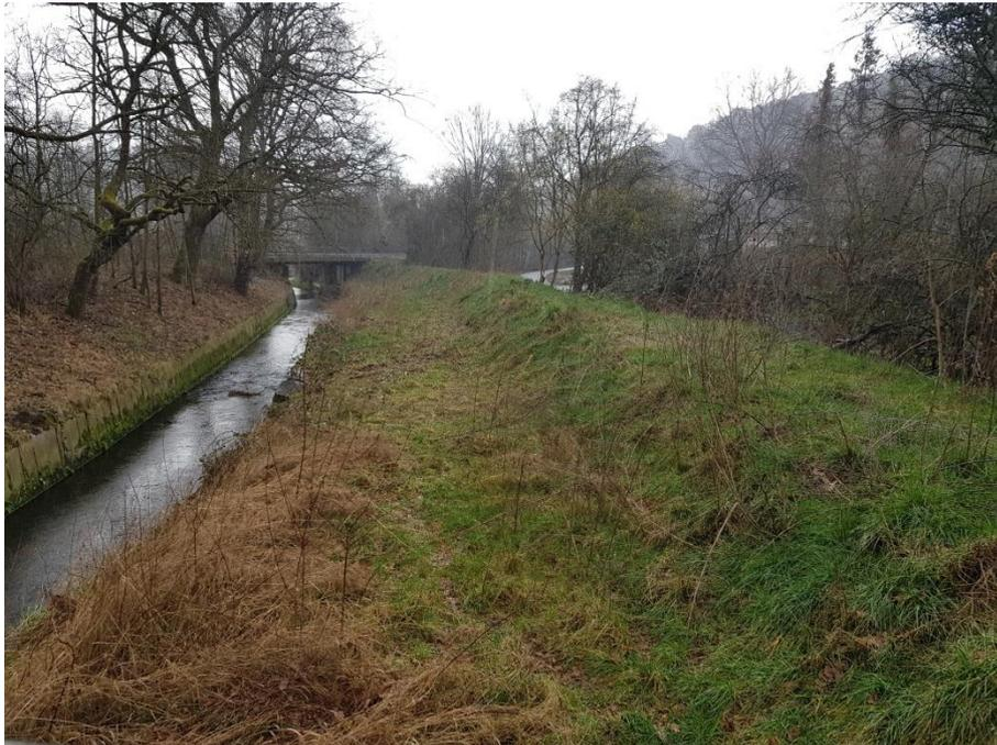
**Abbildung 8 Abschnitt I - provisorischer Damm zwischen Radwegbrücke und Bahnbrücke**
