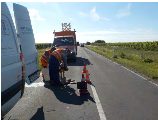
Bild 23: Kernbohrung Asphalt
