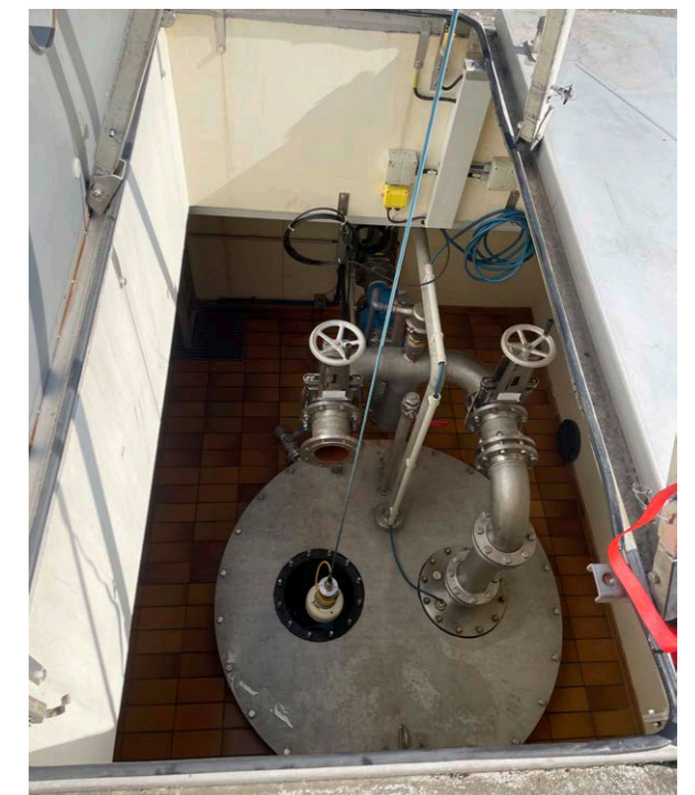
Kamerabefahrung eines Schutzbrunnens
