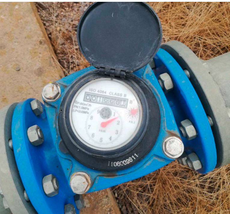
Wasseruhr zur Messung der entnommenen Wassermenge
