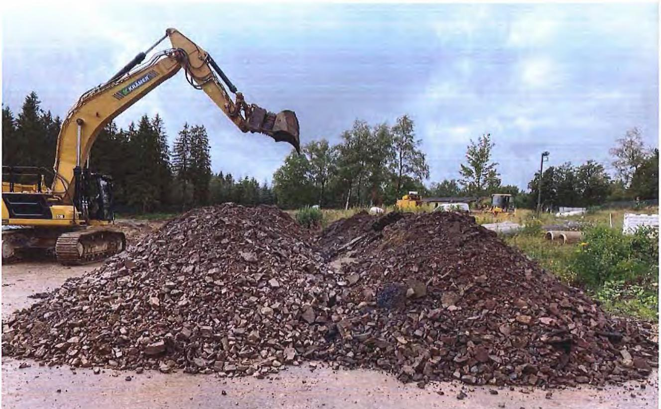
Bild 4: angefallene Massen der Asphaltberäumung
