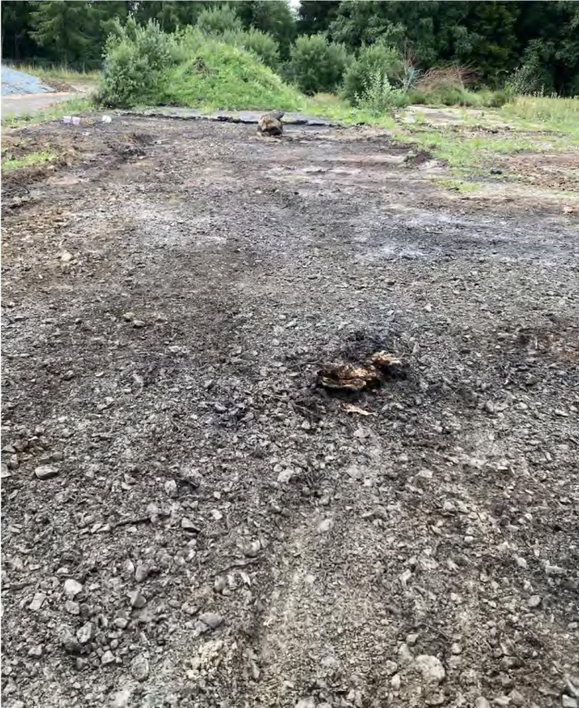
*Bild 3: Fläche nach Beräumung der organoleptisch auffälligen Schwarzdecken und Tragschichten*
