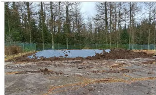
Foto 11: Abgedeckter Oberboden am 20.03.23, Blickrichtung S
