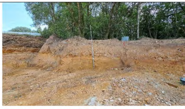
Foto 20: Aushubsanierung am 04.07.23, Bestimmung Aushubtiefe O-Wand
