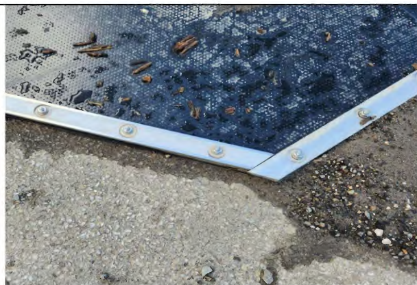
Foto 37: KDB mit Metallschienen und Dichtung auf Asphalt befestigt
