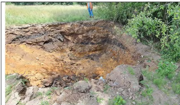
Foto 13: Beginn Aushubsanierung am 27.06.23, SO-Ecke
