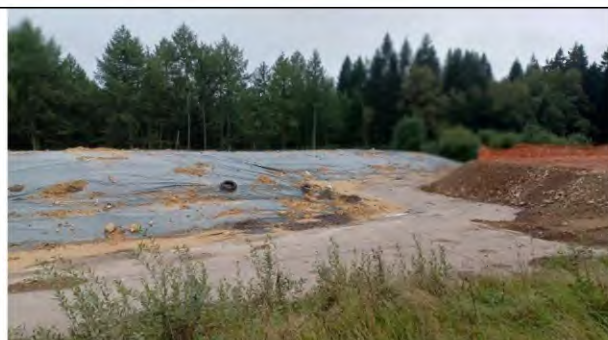
Foto 26: Temporär abgedeckte Bodenmiete, Blickrichtung S
