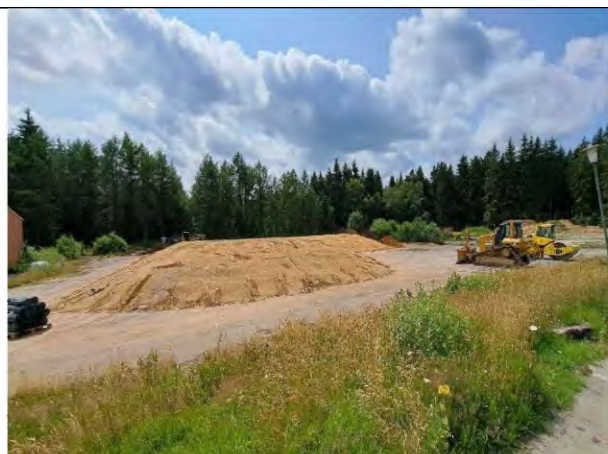
Foto 22: Aufgehaldetes und verdichtetes Aushubmaterial, Blickrichtung S
