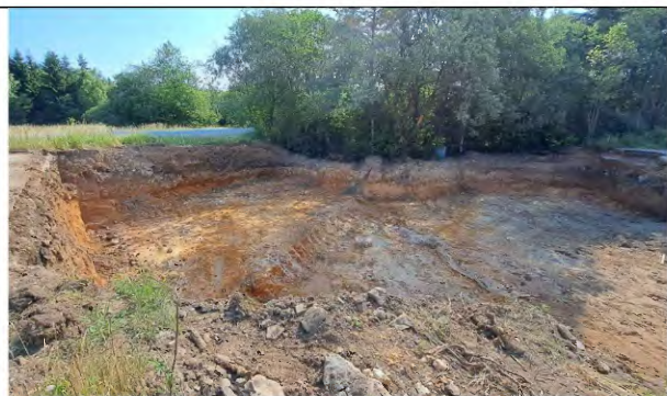
Foto 14: Aushubsanierung am 04.07.23, Blickrichtung O
