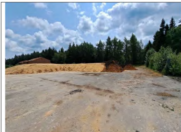
Foto 23: Aufgehaldetes und verdichtetes Aushubmaterial, Blickrichtung S
