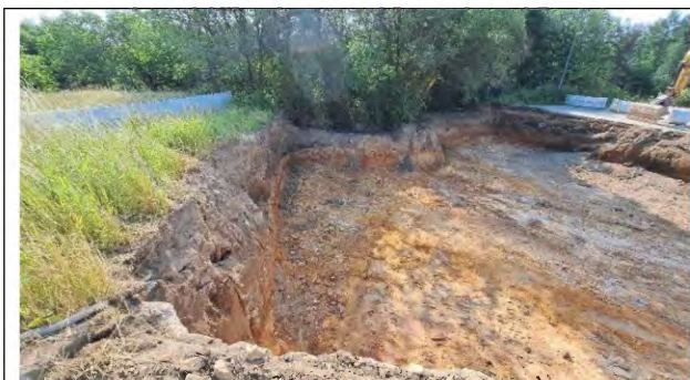
Foto 17: Aushubsanierung am 04.07.23, Blickrichtung SO
