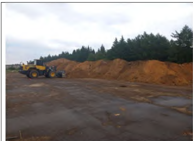
Foto 21: Aufhaldung Aushubmaterial, Blickrichtung SO
