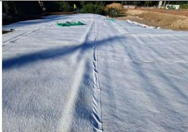
Foto 41: Verlegtes Kunststoffdränelement
