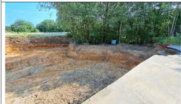
Foto 19: Aushubsanierung am 04.07.23, Blickrichtung NO
