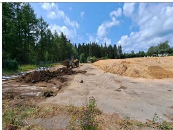
Foto 24: Aufgehaldetes Aushubmaterial, Aufbringung verunreinigter Oberboden, Blickrichtung W
