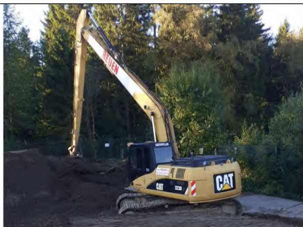
Foto 45: Aufbringung des Oberbodens mit Langarmbagger
