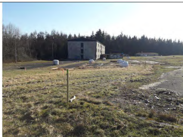
Foto 4: Ausflockung Sanierungsbereich, Blickrichtung S
