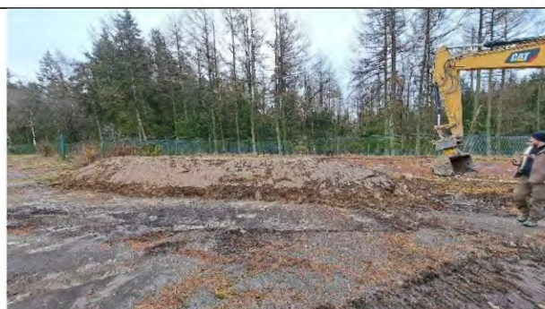
Foto 10: Lagerung/Verdichtung des Oberbodens am 20.03.23, Blickrichtung SO
