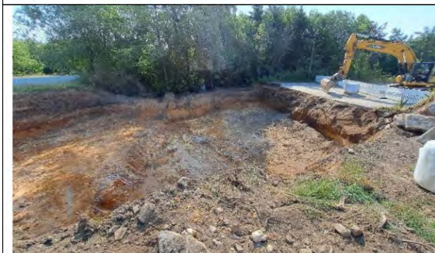
Foto 15: Aushubsanierung am 04.07.23, Blickrichtung SO
