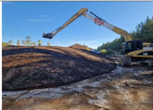
Foto 47: Aufbringung des Oberbodens mit Langarmbagger
