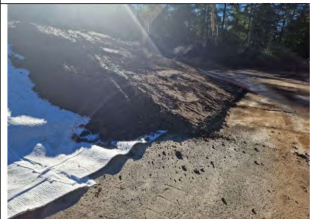
Foto 48: Aufbringung des Oberbodens mit Langarmbagger
