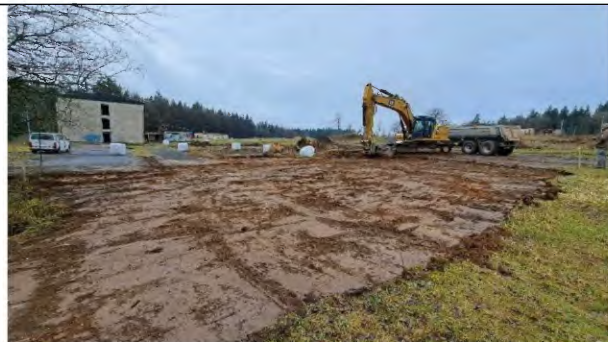
Foto 6: Abziehen des Oberbodens am 20.03.23, Blickrichtung SW
