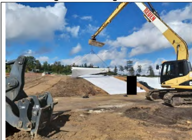
Foto 27: Verlegung Schutzgeotextil auf der Bodenmiete
