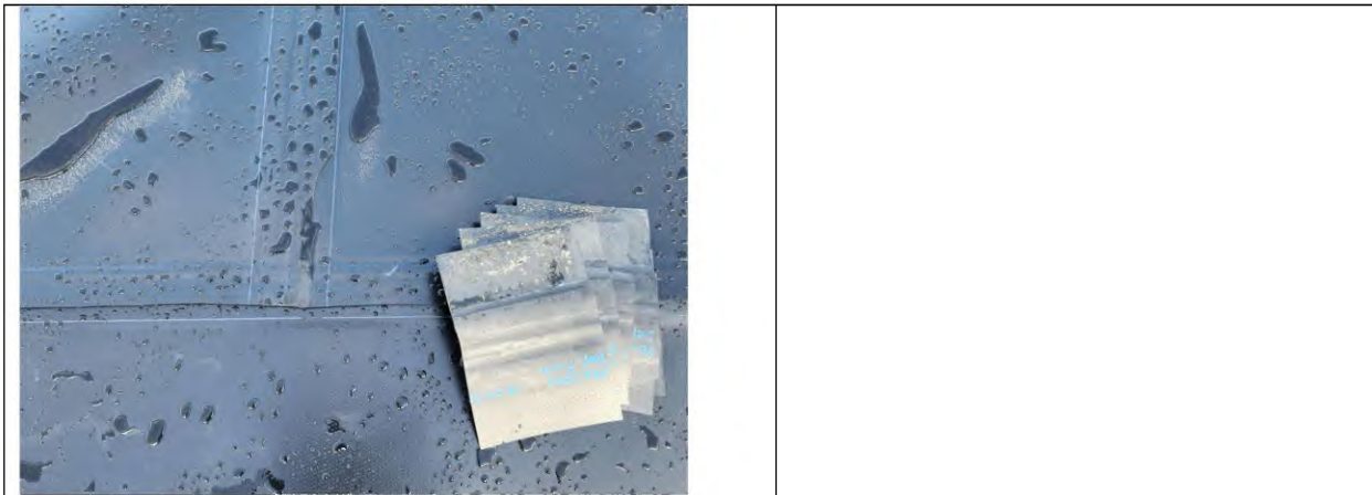
Foto 35: Verlegte KDB, Übergangsstellen der Bahnen
