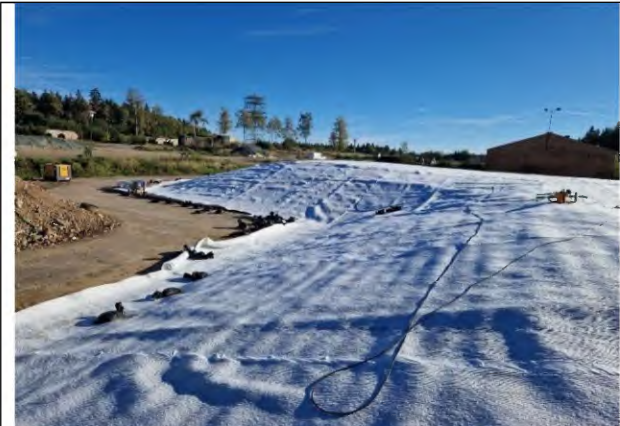
Foto 40: Verlegtes Kunststoffdränelement
