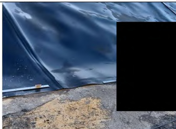
Foto 39: Befestigung der Metallschienen
