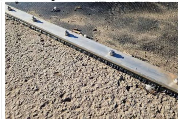
Foto 36: KDB mit Metallschienen und Dichtung auf Asphalt befestigt
