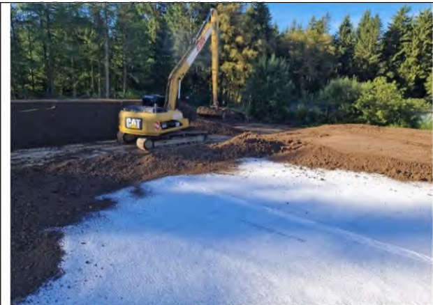
Foto 46: Aufbringung des Oberbodens mit Langarmbagger
