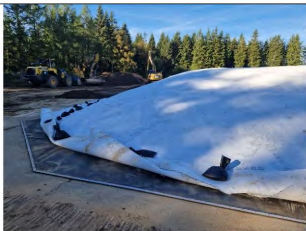
Foto 43: Verlegtes Kunststoffdränelement
