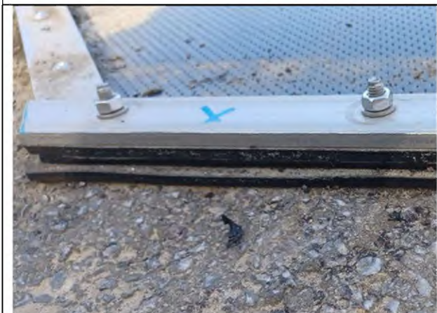
Foto 38: KDB mit Metallschienen und Dichtung auf Asphalt befestigt
