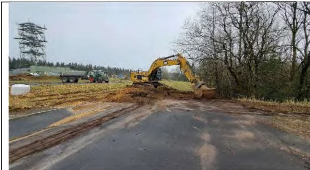
Foto 5: Abziehen des Oberbodens am 20.03.23, Blickrichtung NO
