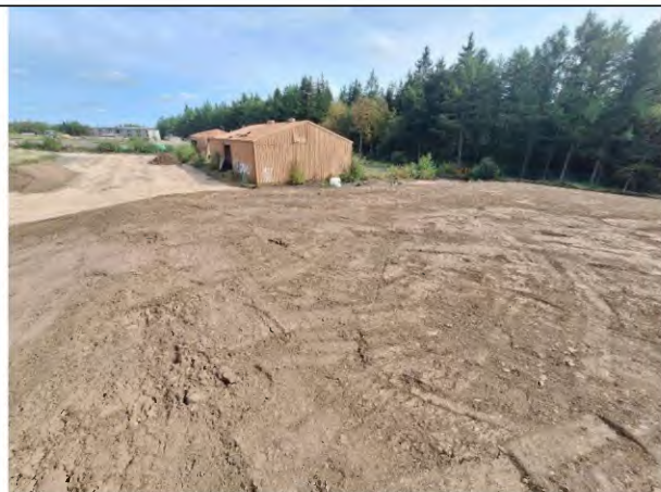
Foto 51: Mit Oberboden bedecktes Sicherungsbauwerk
