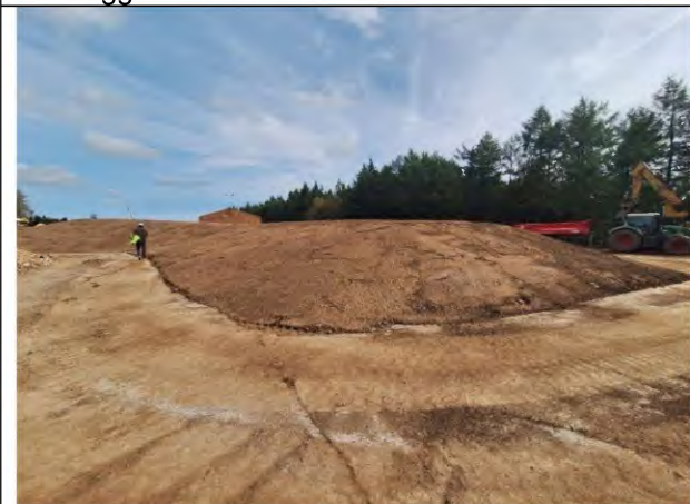
Foto 50: Mit Oberboden bedecktes Sicherungsbauwerk
