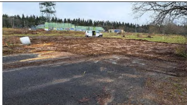
Foto 8: Abziehen des Oberbodens am 20.03.23, Blickrichtung NW
