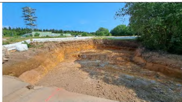
Foto 18: Aushubsanierung am 04.07.23, Blickrichtung NO
