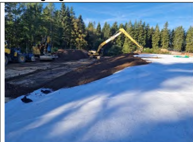
Foto 44: Aufbringung des Oberbodens mit Langarmbagger
