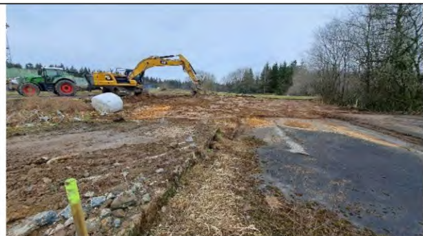
Foto 7: Abziehen des Oberbodens am 20.03.23, Blickrichtung NO
