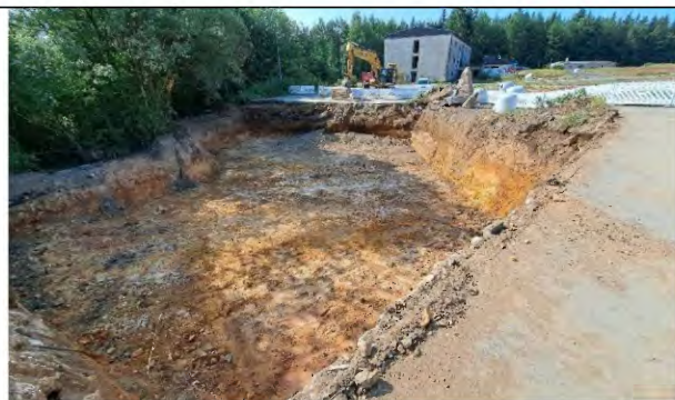
Foto 16: Aushubsanierung am 04.07.23, Blickrichtung S
