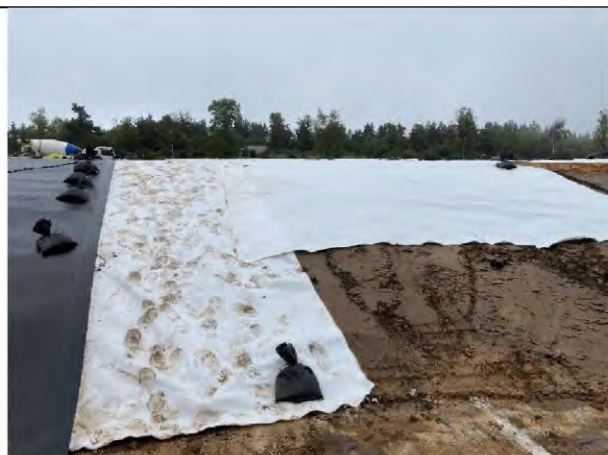
Foto 28: Schutzgeotextil auf Bodenmiete
