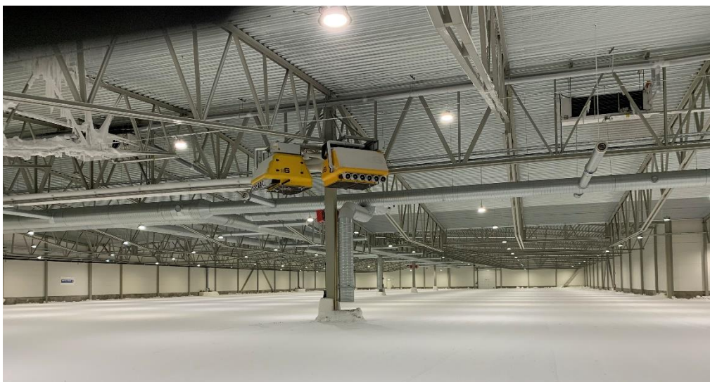
Die Prüfhalle von innen. Die gelben Anbauten sind Schneekanonen.
