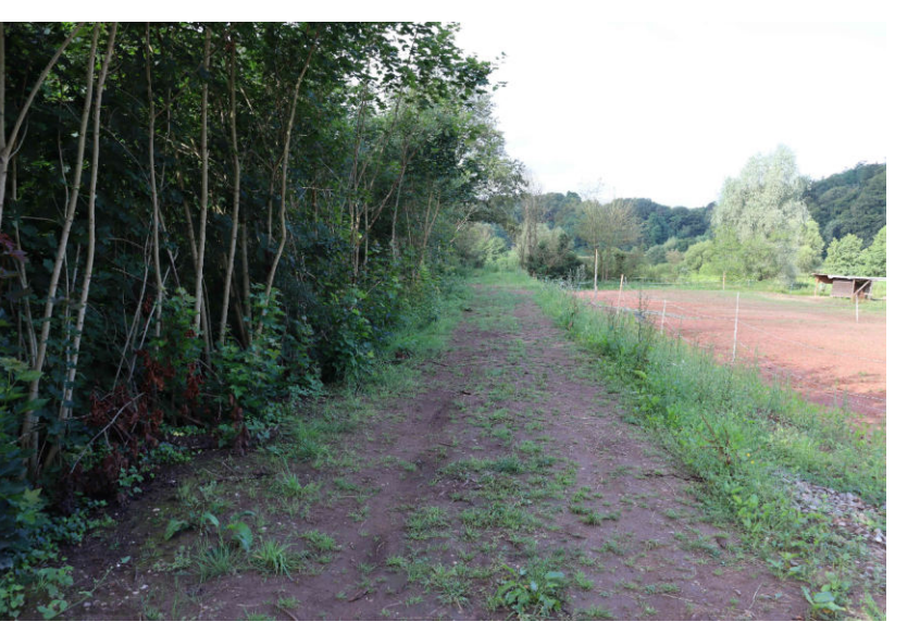
Bild 14: Zufahrt Bereitstellungfläche, Weg wird geschottert
