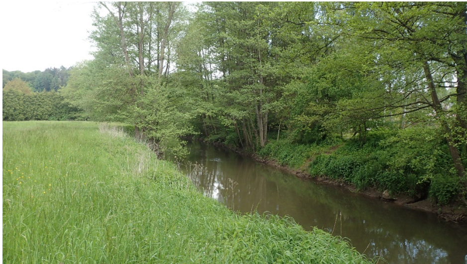
Bild 3: Unterwasserseitiges Ende (Seg. 57) von Bauabschnitt 3 im Bereich der Kleingartenanlage Rimschweiler.
