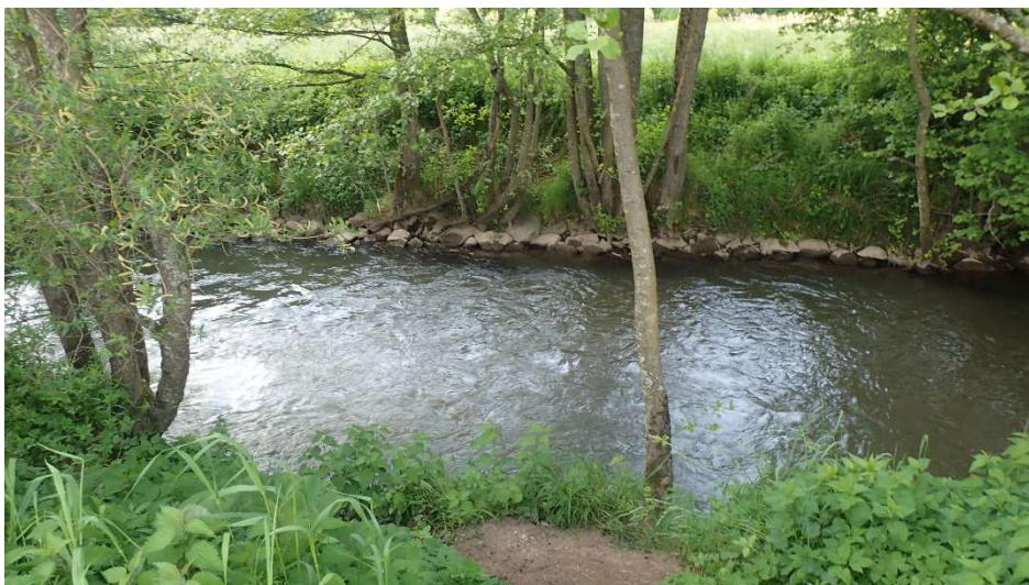
Bild 11: Auch hier sind die Ufer weitestgehend durch Steinschüttung gesichert.
