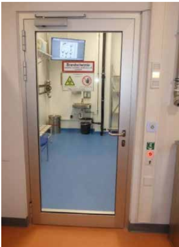
Eingang zur Schleuse
