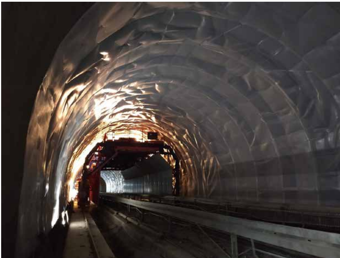
Schutzeinhausung am Tunnel
