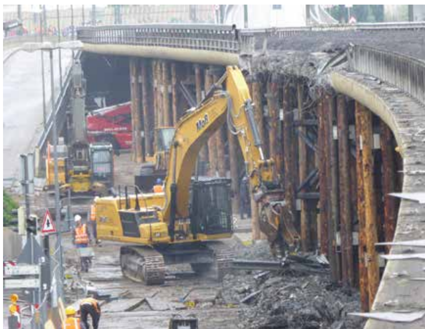
Abrissbagger beim Teilabriss der Pilzstraße
