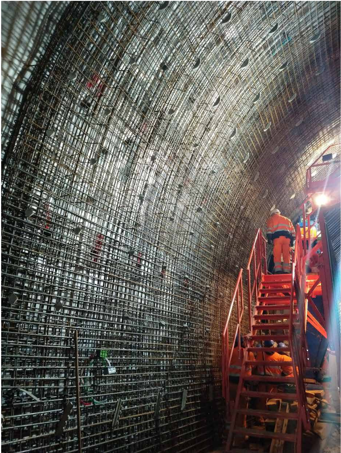
Innenschale aus Beton
