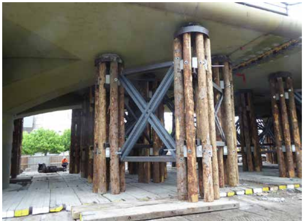
Spezielle Unterkonstruktionen sichern den Abriss
