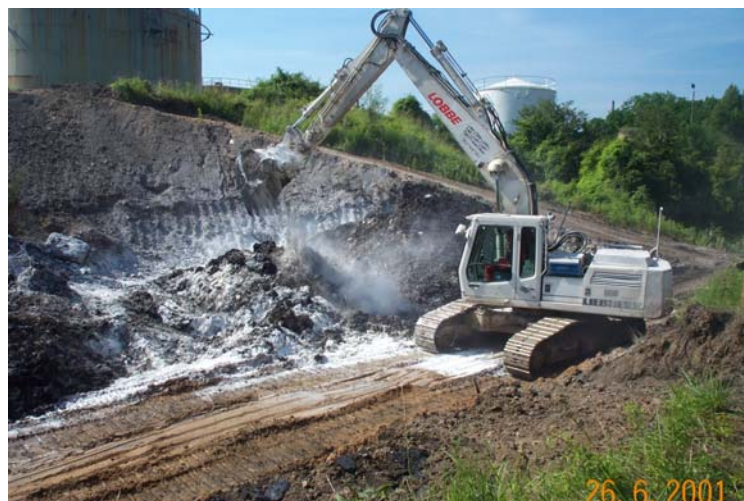
Abb. 5: Teerkonditionierung mit Tieföffelbagger
