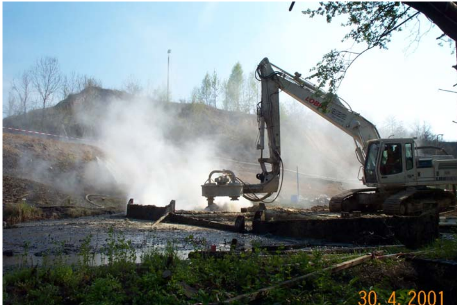
Abb. 6: Teerkonditionierung mittels Vertikalfräse
