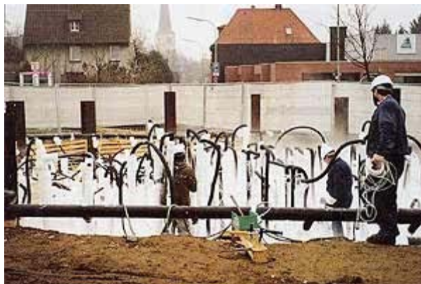
Abb. 4: Vereisung eines Teerölbehälters (Foto: Bauer + Mourik Umwelttechnik GmbH & Co.)
