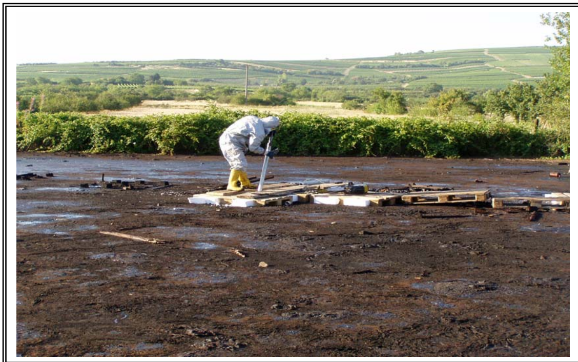
Foto 9: Bohrarbeiten, Vorbereitung einer Schutzverrohrung
