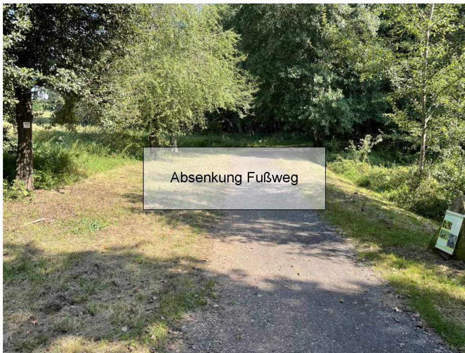
Bild: Absenkung Fußweg mit Einleitung in das Vorland des Glan (Starkregen)
